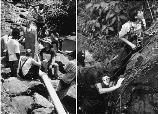
Von links nach rechts: Am Wasserfall wird die Staumauer errichtet; über 50 Meter Stahlrohr müssen verlegt werden, um das Wasser von der Staumauer zur Turbine zu leiten; am Fuß des Wasserfalls wurde das Maschinenhaus errichtet, in ihm befinden sich die Turbine, der Generator und die elektronische Steuerung der Anlage.
