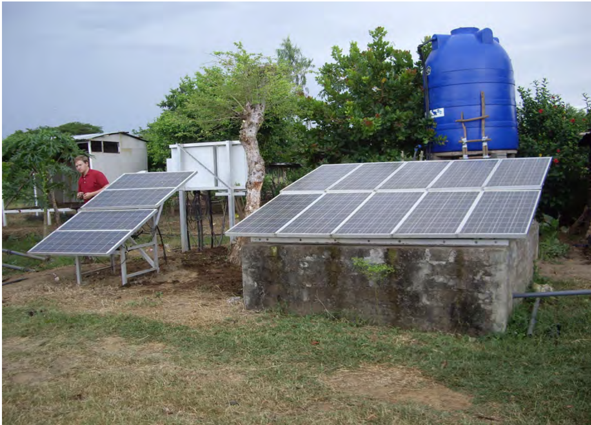
Stromversorgung für die SPS und die Pumpen, rechts der Hochtank
