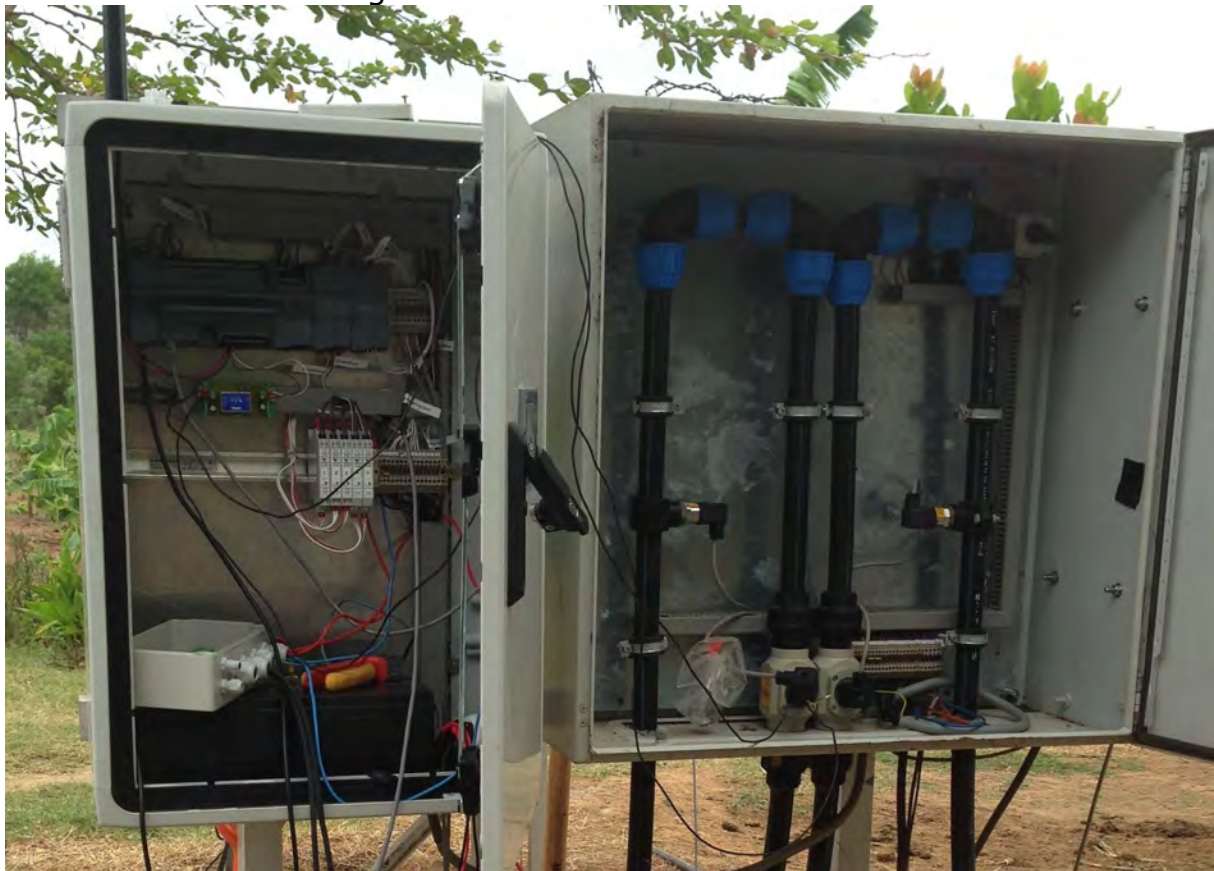
Die beiden Schaltschränke auf Titos Finca, der Schrank links ist neu.
