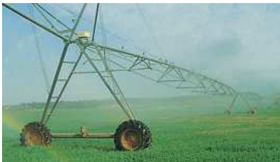
Abbildung 5 Bewegliche Beregnungsanlage (Klett, 15.04.2013)
