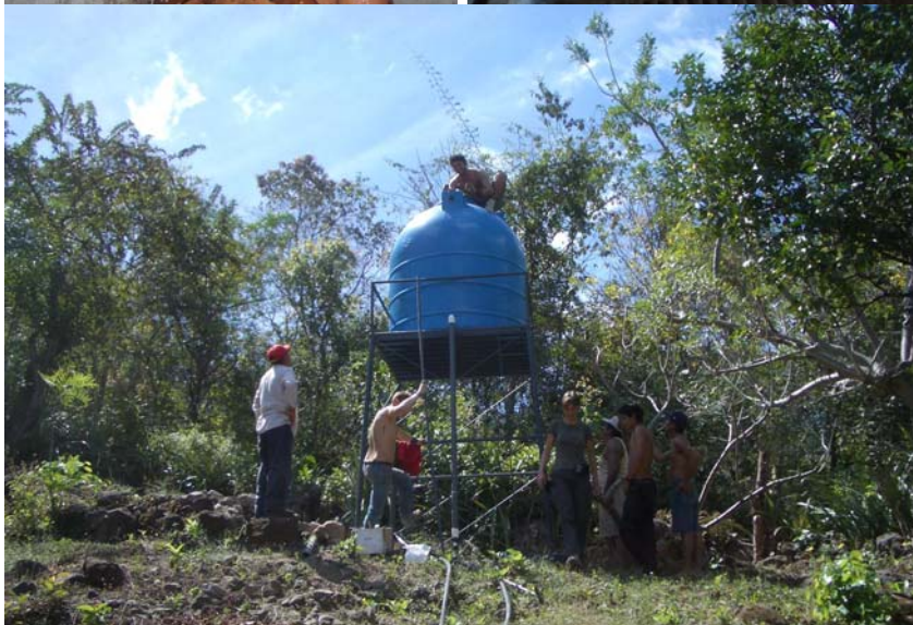
Von dem Brunnen wird das Wasser zunächst in einen hochgelegenen Tank gepumpt, bevor es mit einem Druck von ca. 0,8 bar zum kommunalen Zentrum und – wahlweise – zum Feldbewässerungssystem geleitet wird.
