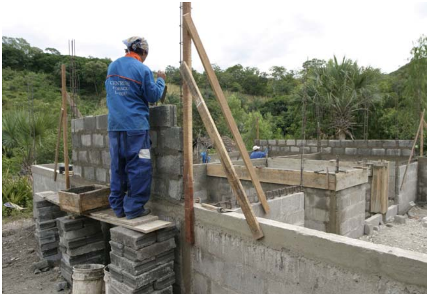
November 2004: Der Bau des kommunalen Zentrums beginnt
