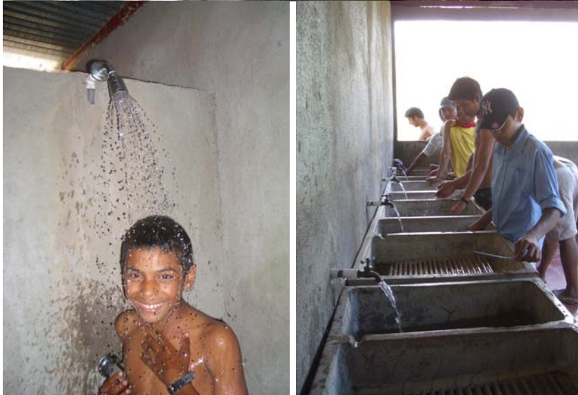
Auf der Rückseite des kommunalen Zentrums befinden sich Waschbecken und zwei Duschen.
