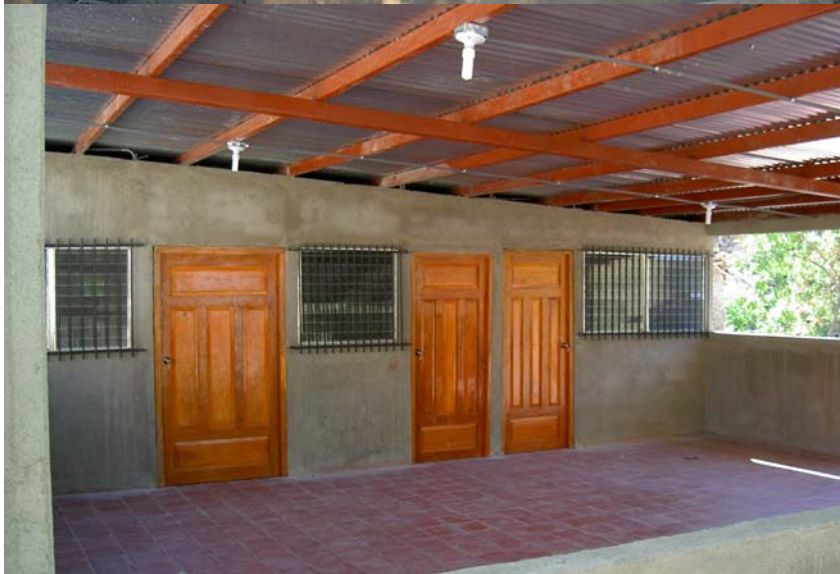
März 2005: Der Hausbau ist – bis auf die Installation der solaren Versorgungssysteme abgeschlossen
