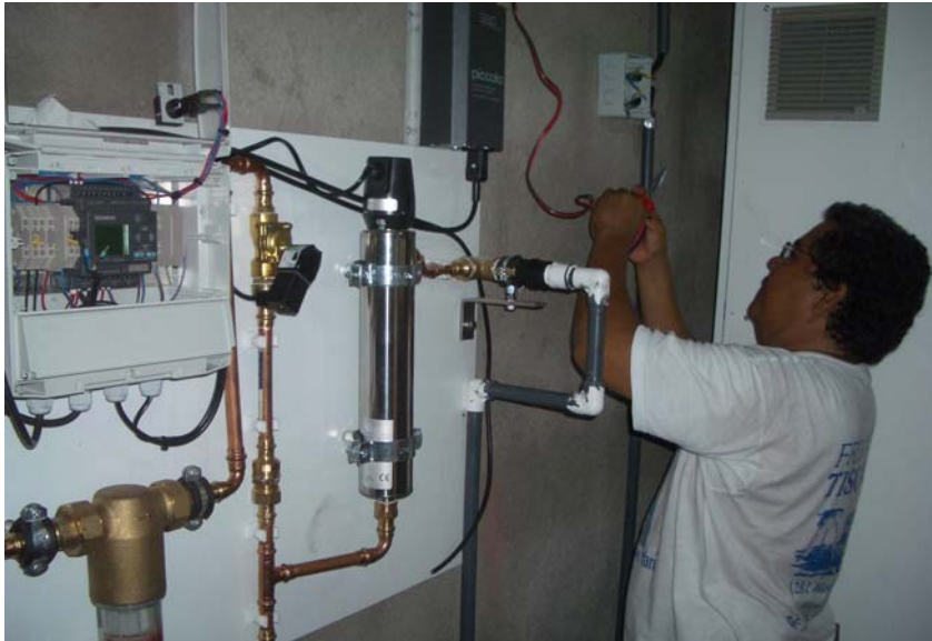
Mai 2006: Installation des letzten Moduls – der Trinkwasseraufbereitung
