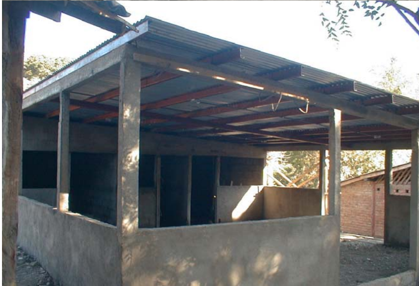
Januar 2005: Das Zentrum ist im Rohbau fertiggestellt
