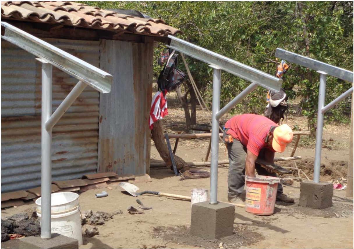
Das Tragegestell für die Module wird einbetoniert
