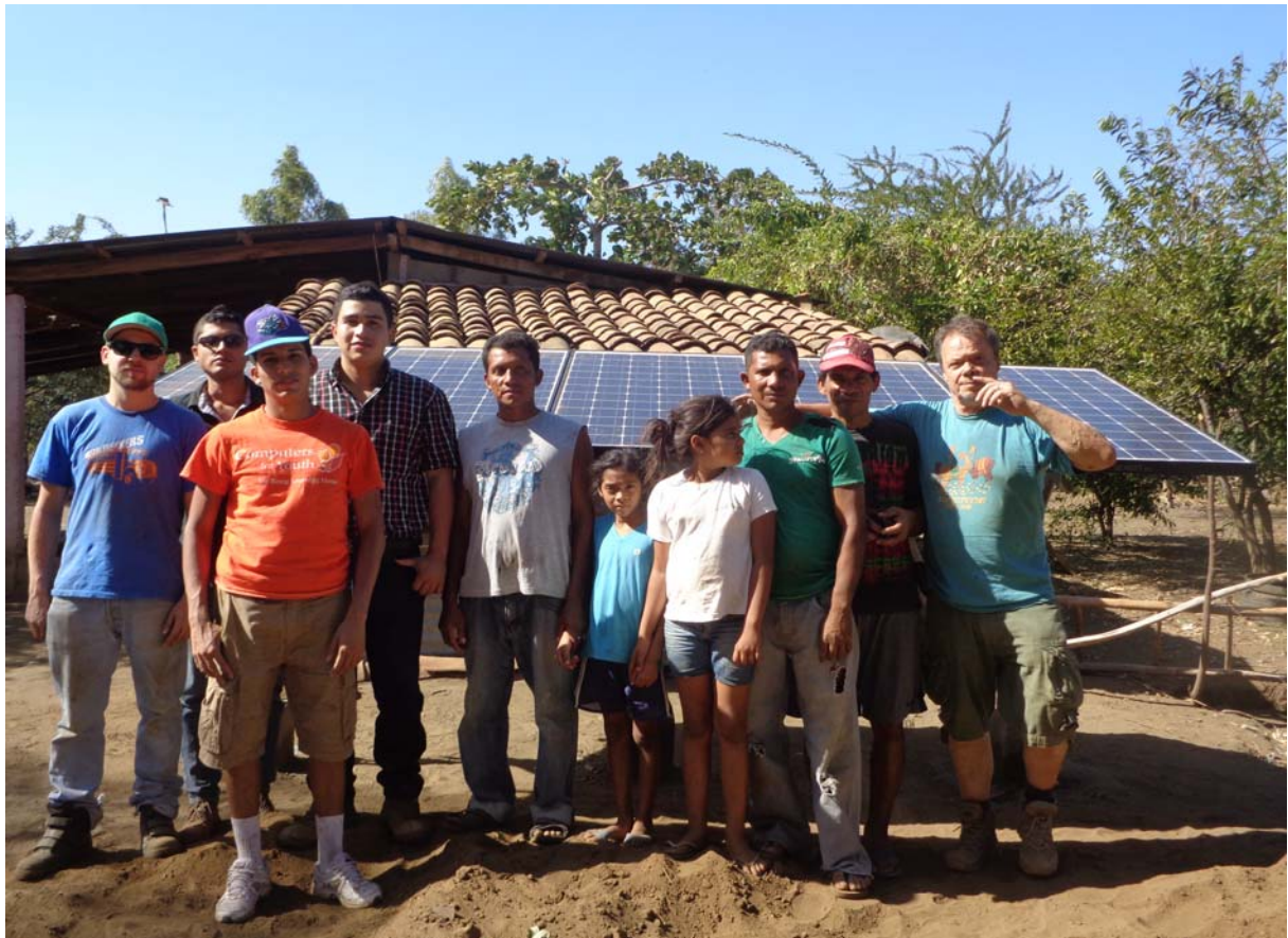
Das solare Pumpsystem ist fertiggestellt. Der Montagetrupp präsentiert sich! (Dritter von rechts: Santos Jimenez)
