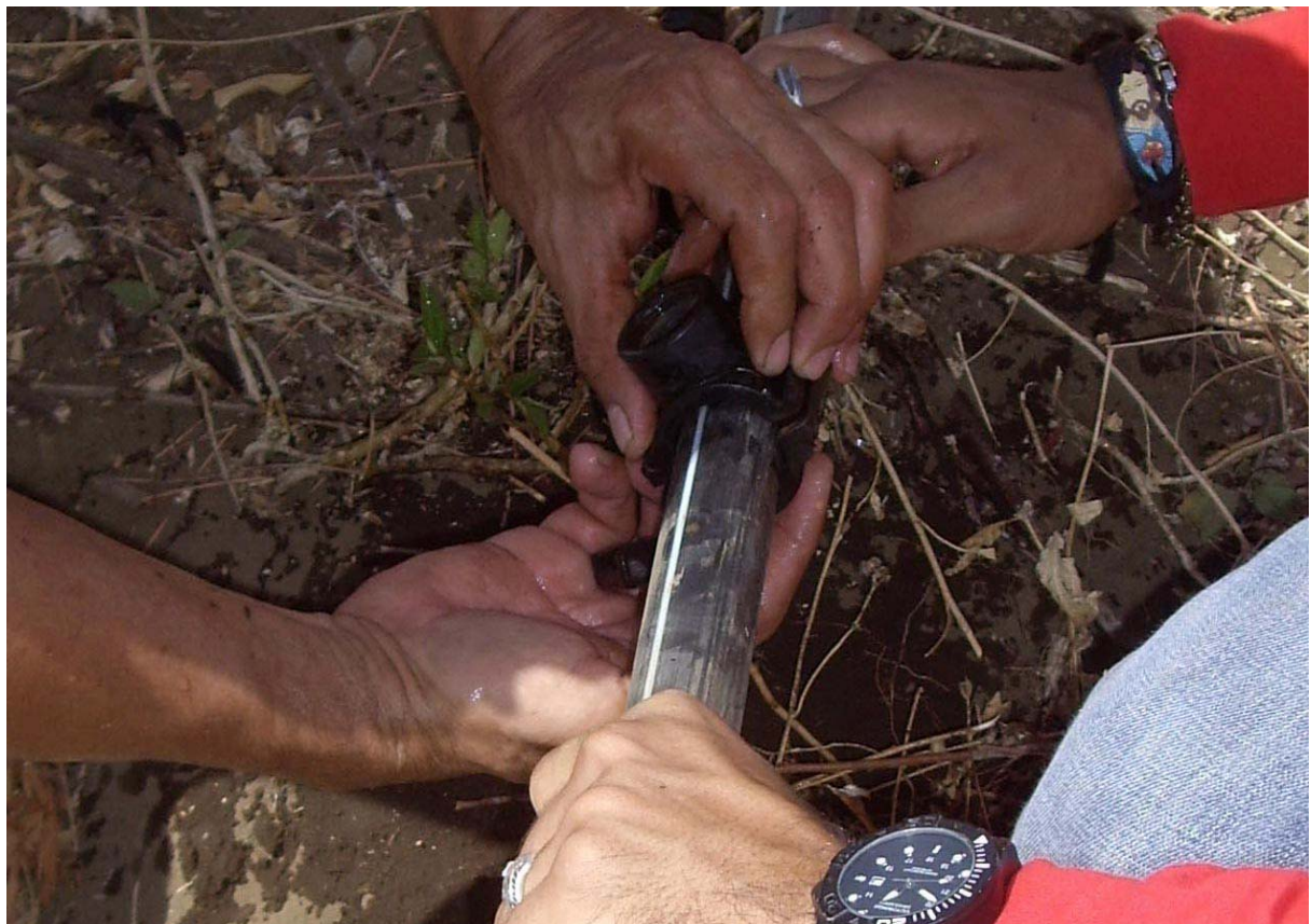
Montage der Andockschelle, die einen Anschluss des Tropfbewässerungsschlauchs erlaubt
