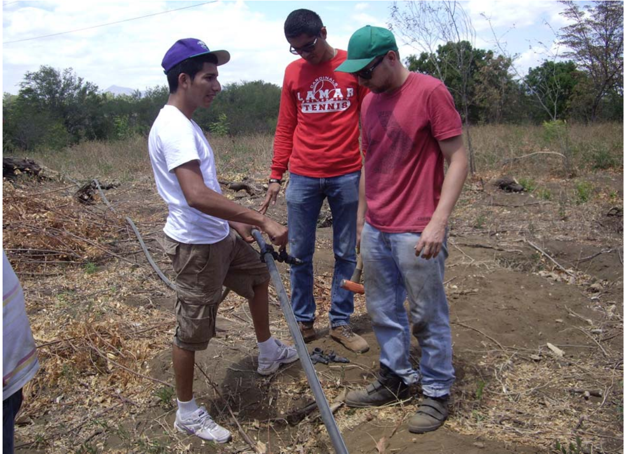
Verlegung der Hauptleitung für das Tropfbewässerungssystem
