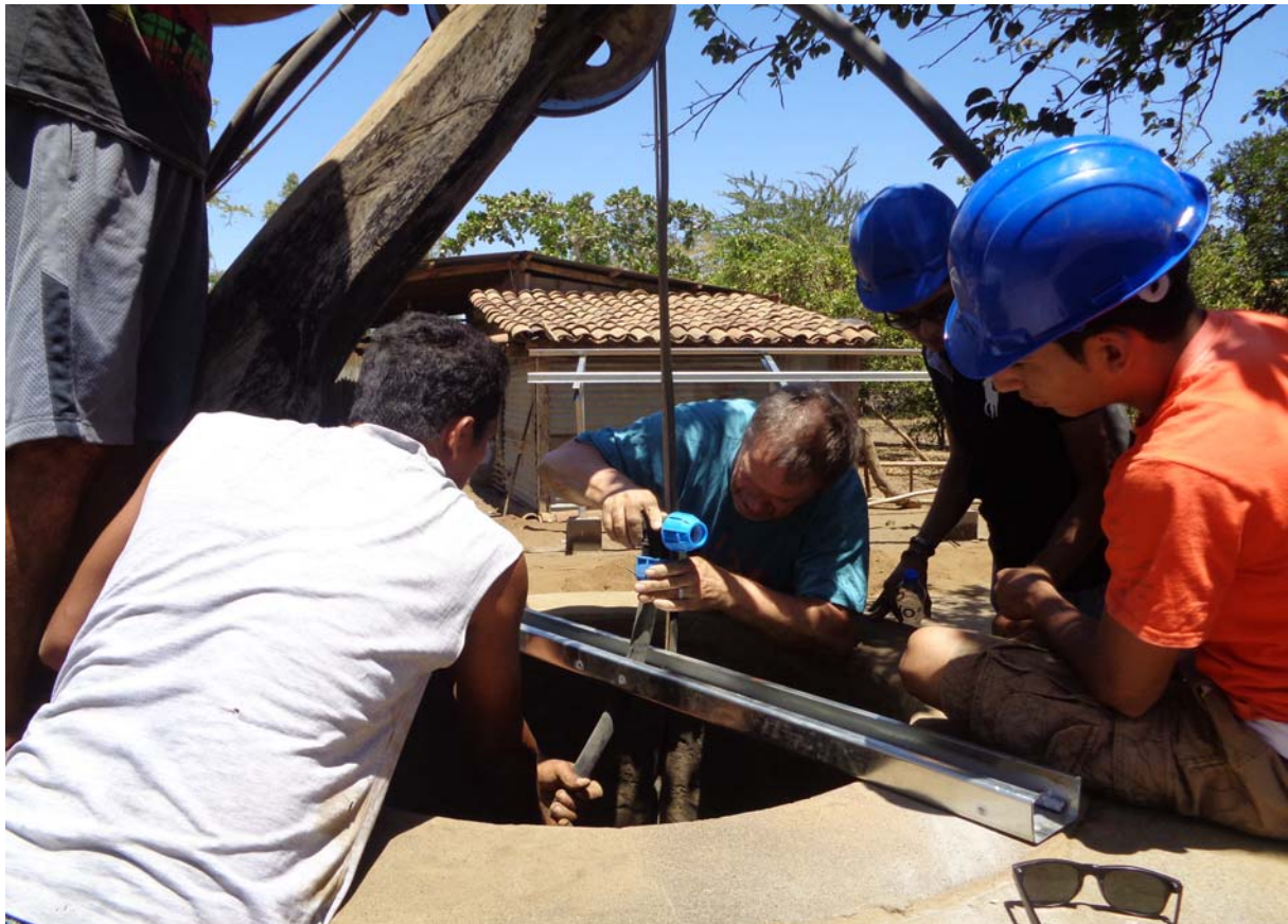
Absenkung der Pumpe
