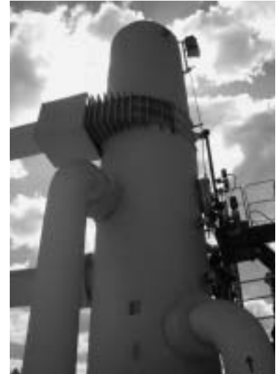
Dampfleitungen und Separator eines geothermischen Kraftwerkes im Gebiet San Jacinto-Tizate. – Fotos: Autoren
