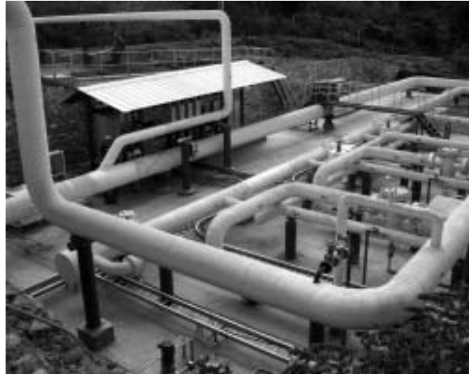
Dampfleitungen und Separator eines geothermischen Kraftwerkes im Gebiet San Jacinto-Tizate. – Fotos: Autoren
