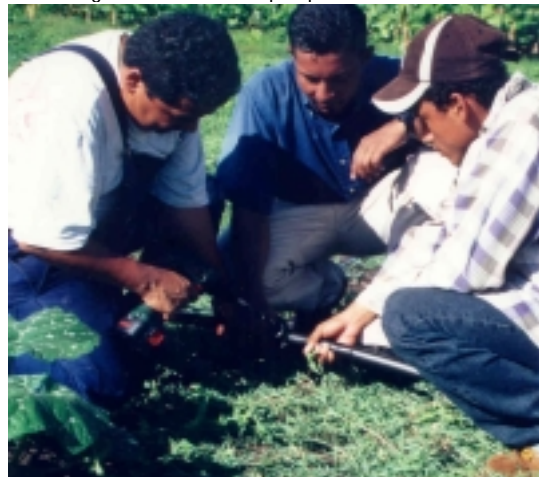
Installation des Tropfbewässerungssystems
