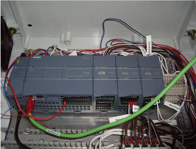
Zur Überwachung und Steuerung der entfernten Anlagen in Nicaragua kommt die Fernwirktechnik TeleControl Basic von Siemens zum Einsatz.
