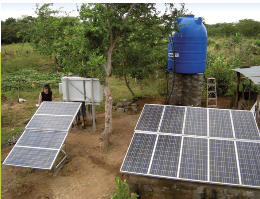
01 Mithilfe von Sonnenenergie betreiben die Hamburger Schüler Bewässerungssysteme, um in Trockenperioden Grundwasser an die Erdoberfläche zu transportieren und damit Felder bewässern zu können
